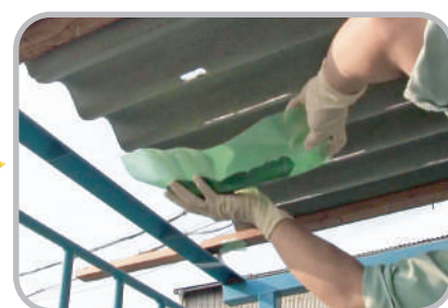
⑥当て板の場合はビス止めします。 テープの場合は穴に貼ります。
