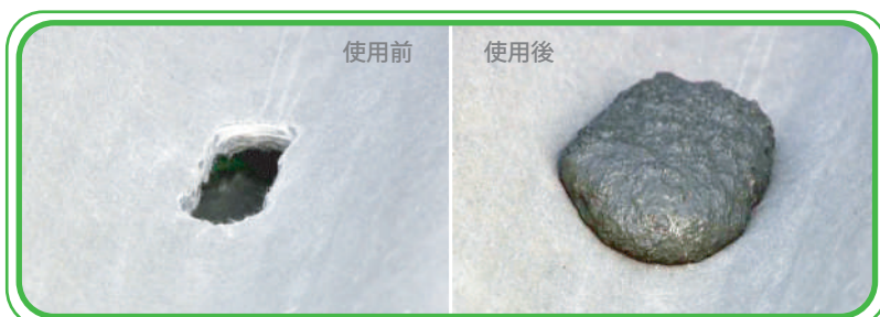
⑧完成です。スレートの穴がふさがり、雨漏りを止めます。
