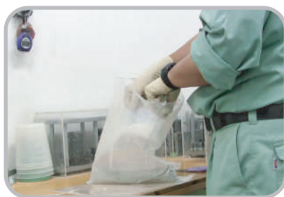
②補修材に樹脂を入れます。
