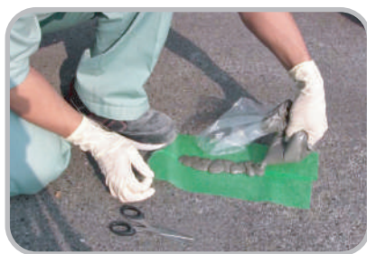
⑤そこに補修材を塗付けます。
